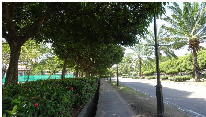
Gambar 1 : Penyediaan laluan pejalan kaki di Sutera Harbour, Kota Kinabalu yang menghubungkan satu kawasan ke kawasan lain. Sumber : JPBW
